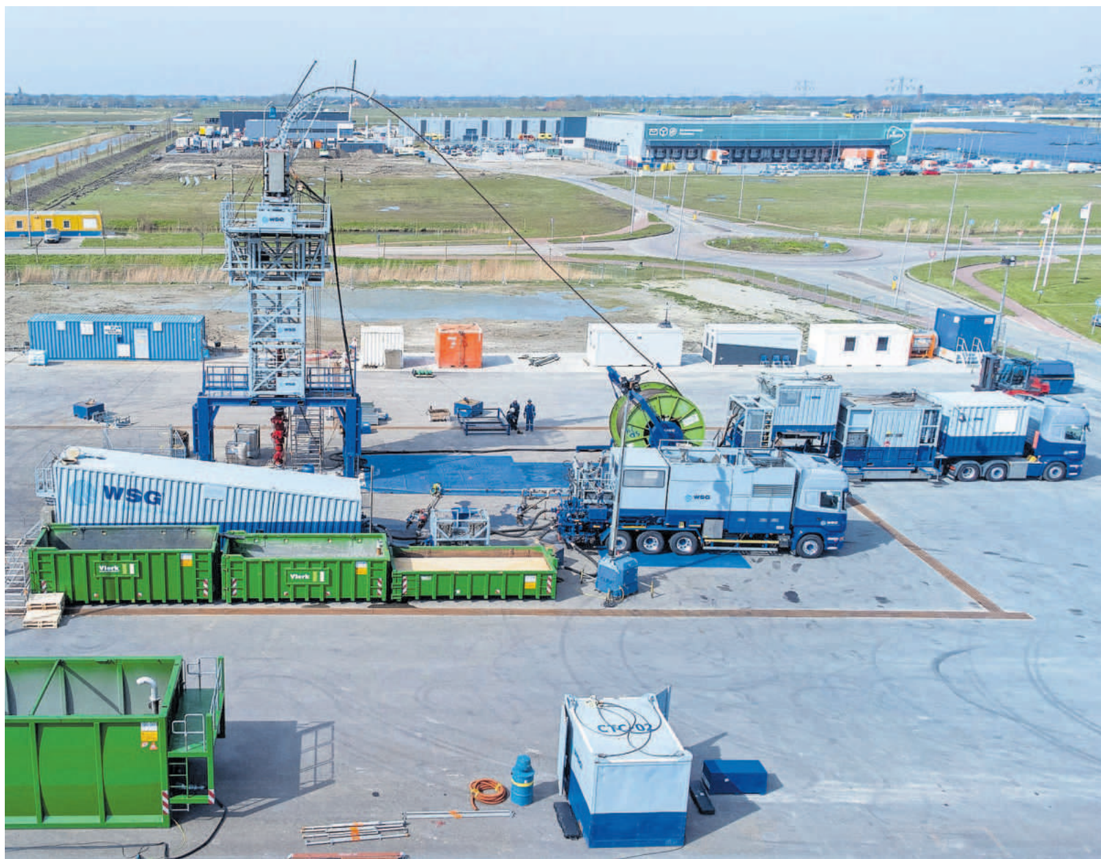
De technische installatie voor de proefboring naar heet water van vorig jaar. FOTO ANTON KAPPERS
